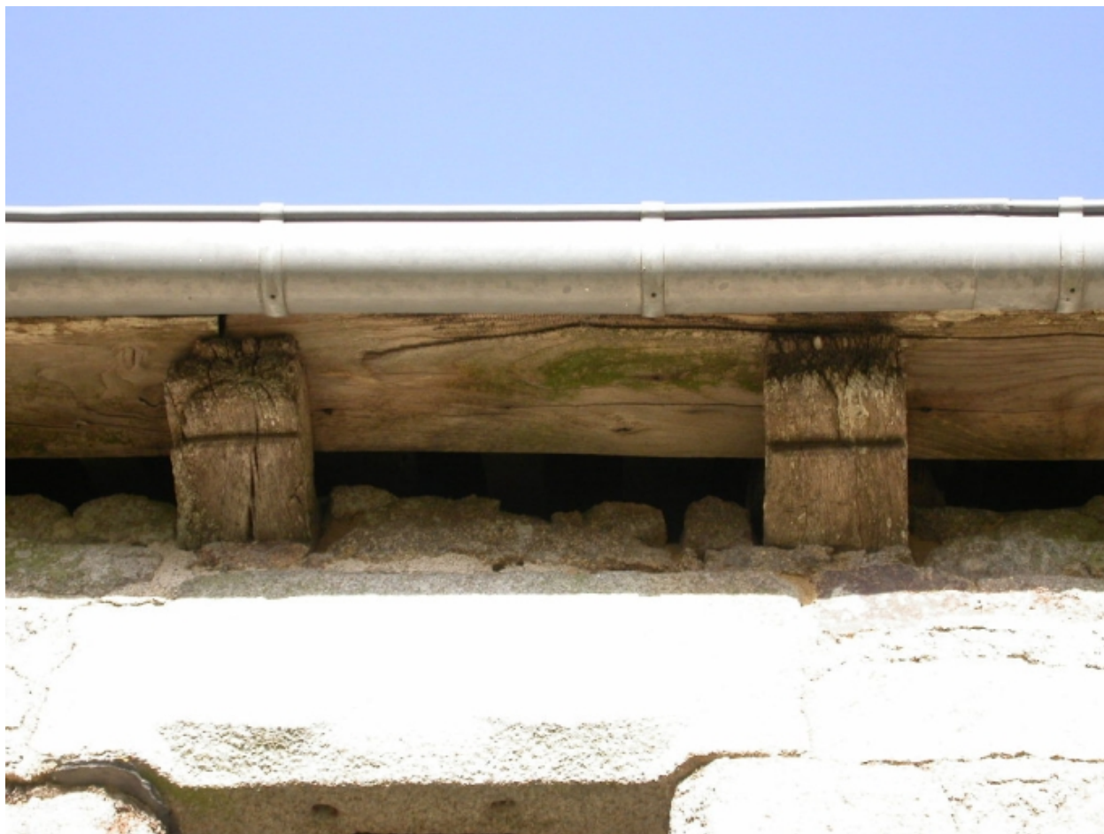
Détail de la corniche
