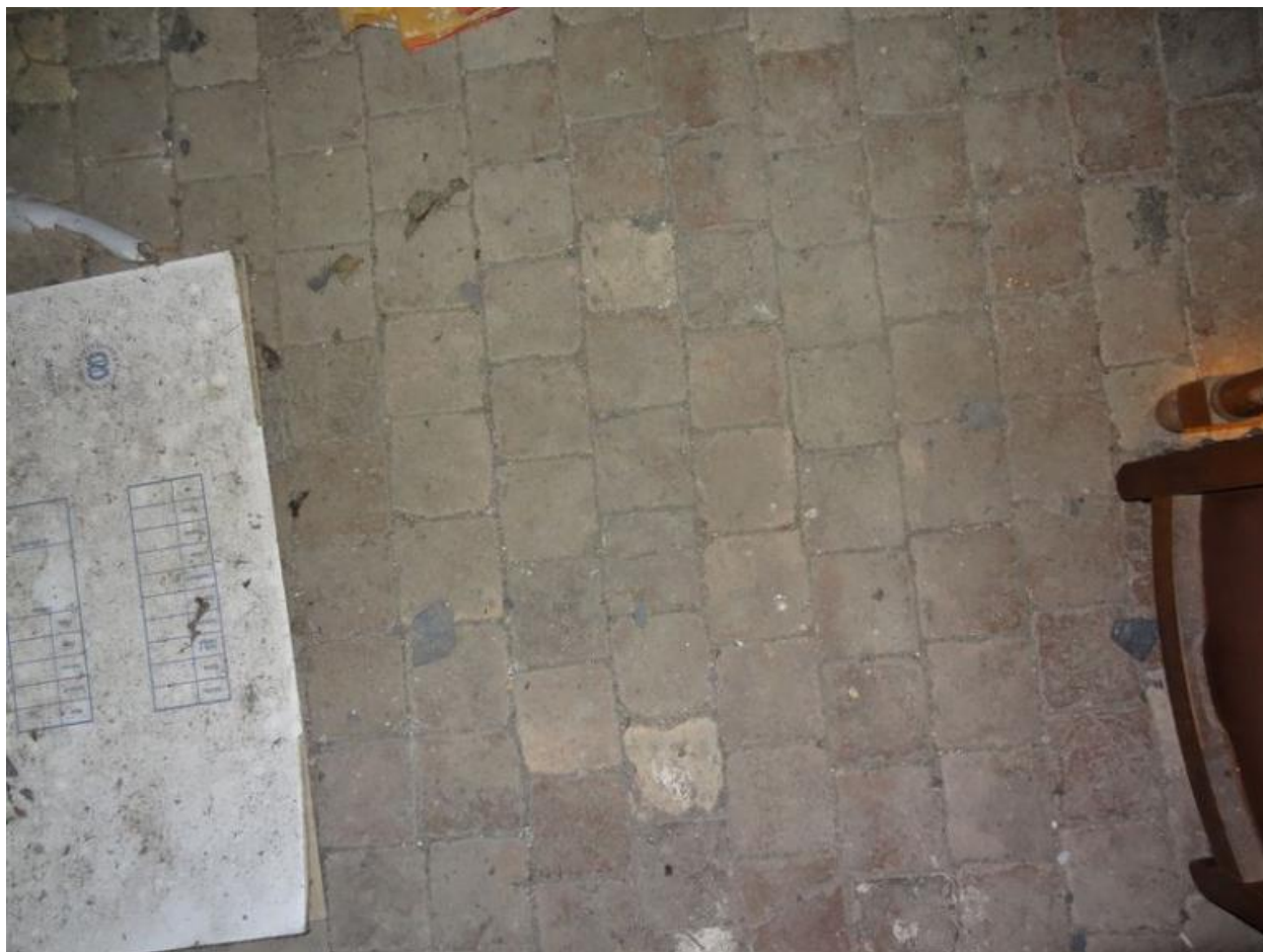
Tomettes de la partie nord du comble
