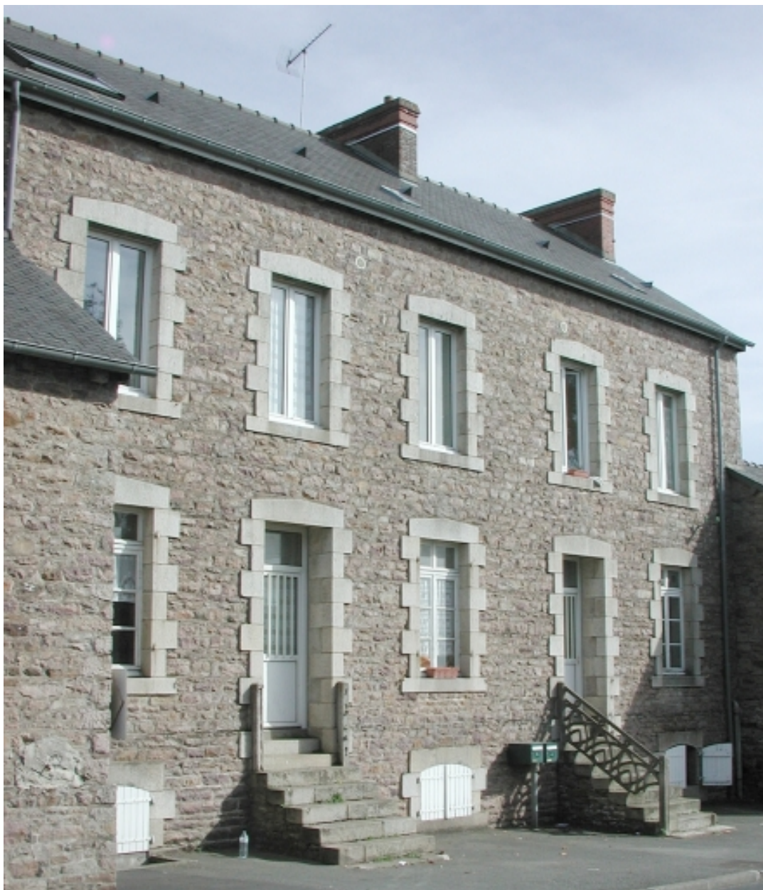
Privés des institutrices. Vue générale de la façade postérieure.
