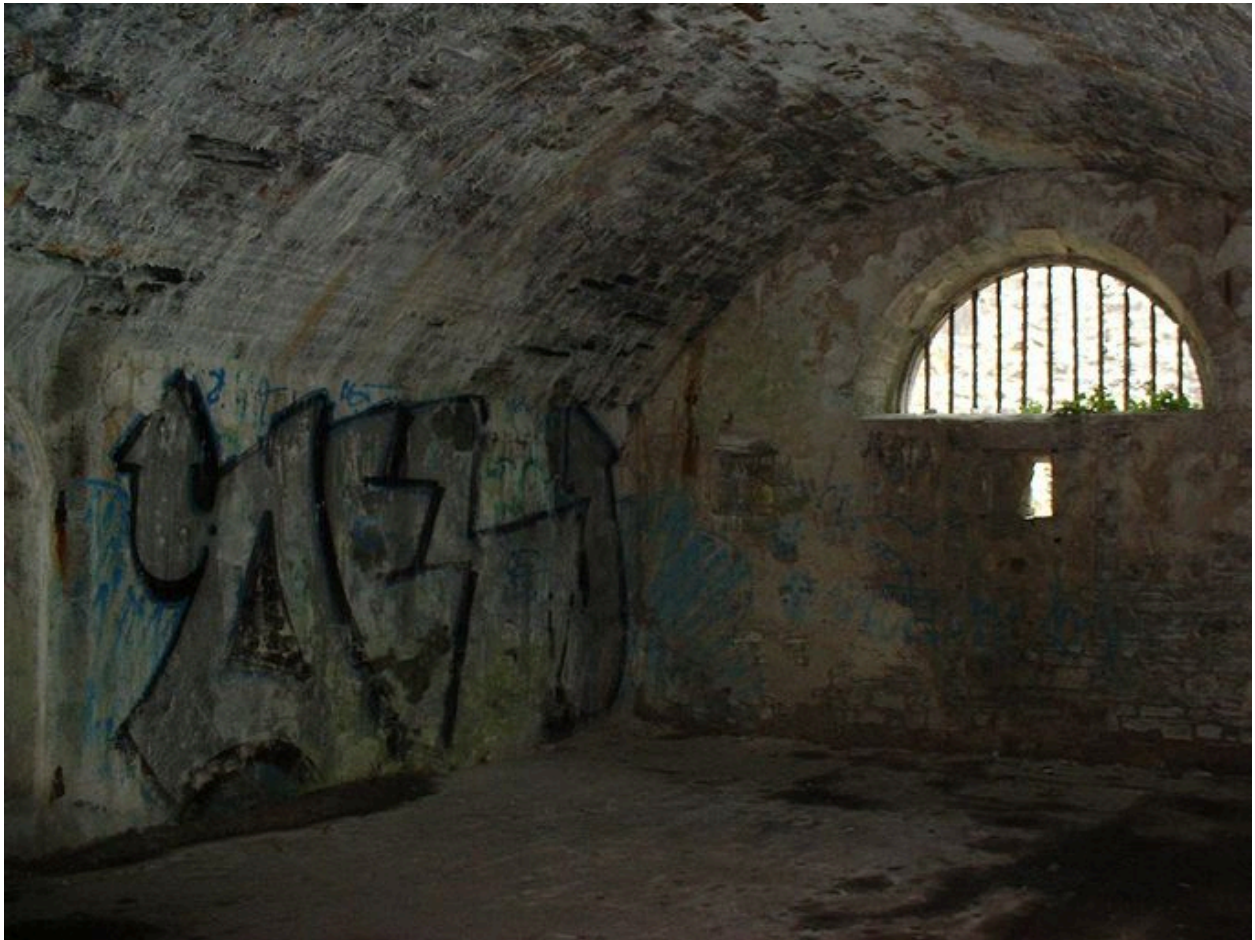
Vue intérieure du réduit de la batterie basse du Kador
