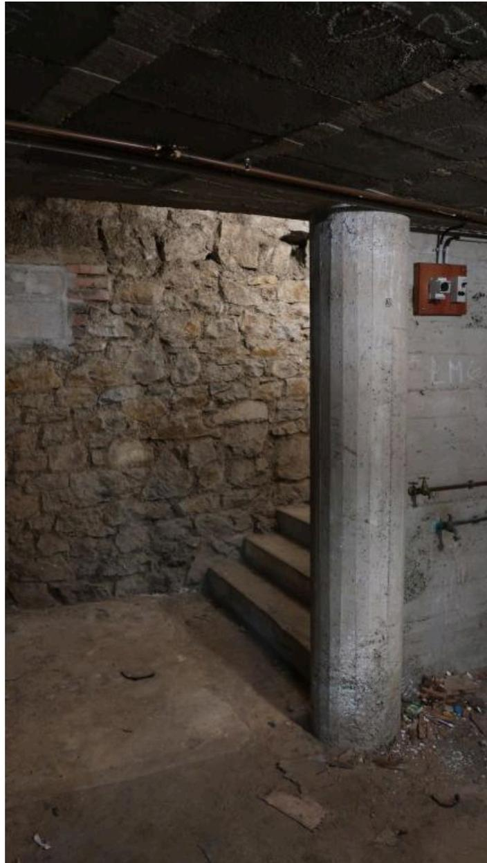
Sous-sol du bâtiment A (G-R. Lefort architecte, 1934) : des soubassements en pierre sous les murs, et en béton sous les planchers.
