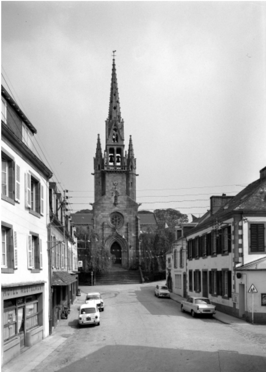
Châteaulin, église paroissiale Saint-Idunet : vue générale clocher et porche d'entrée, état en 1972
