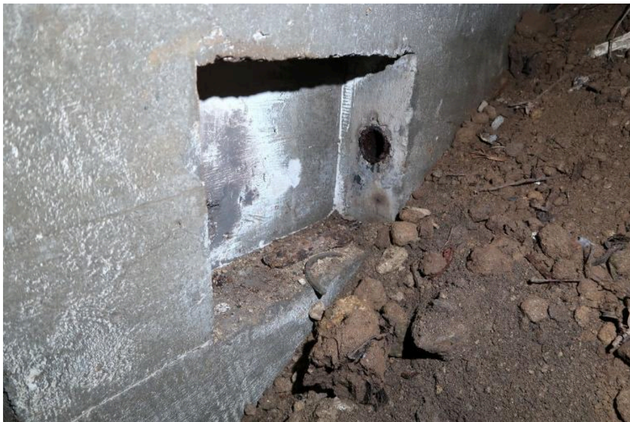
Vue de l'entrée sud : niche murale avec passage de câble
