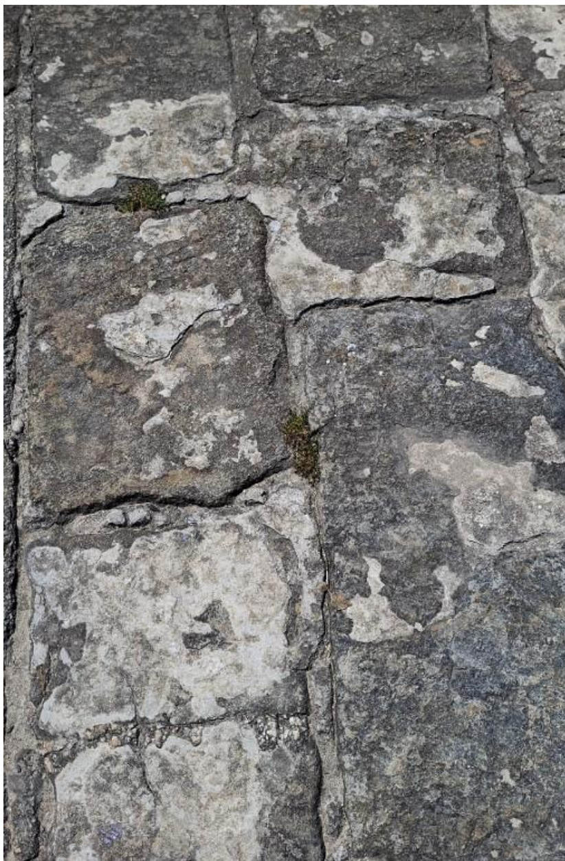
Le vieux quai : détail de mise en oeuvre
