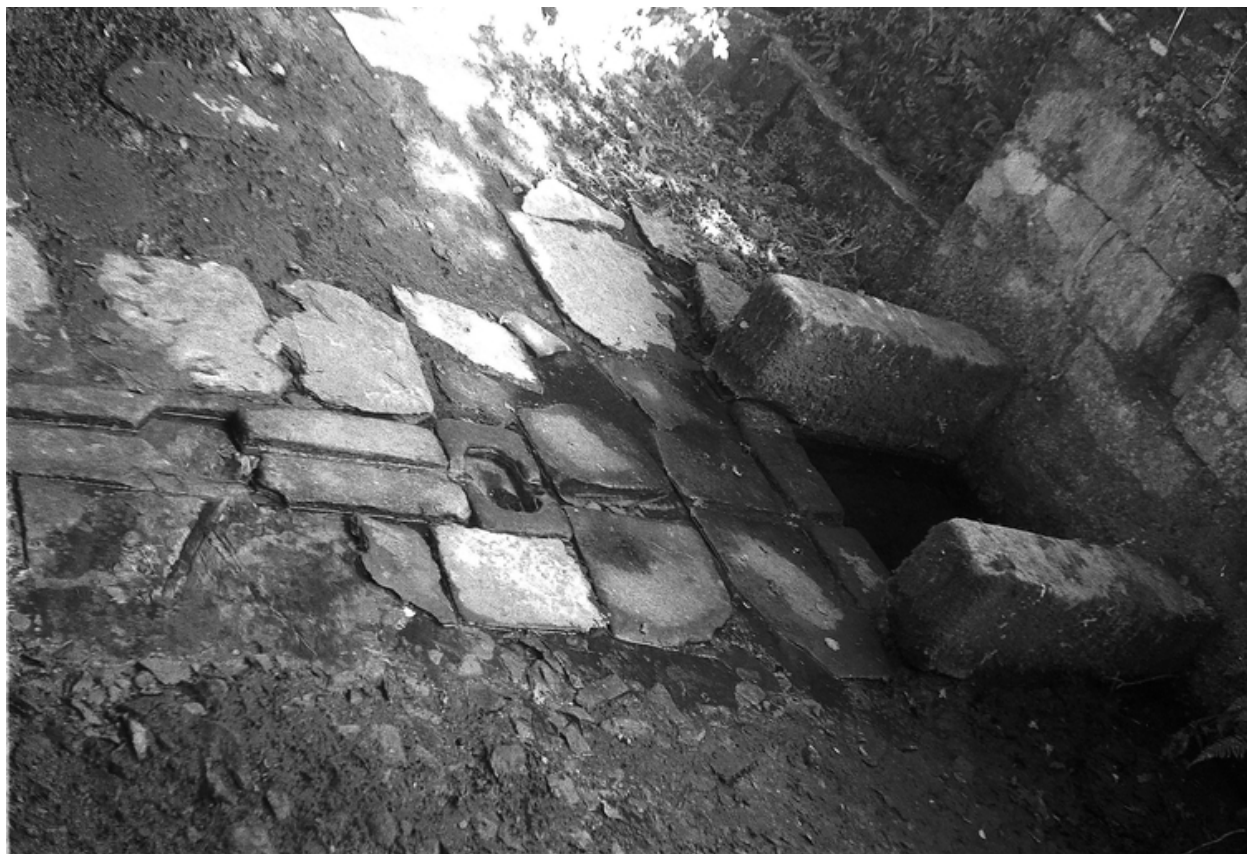
Fontaine : détail du bassin et de la rigole d'écoulement
