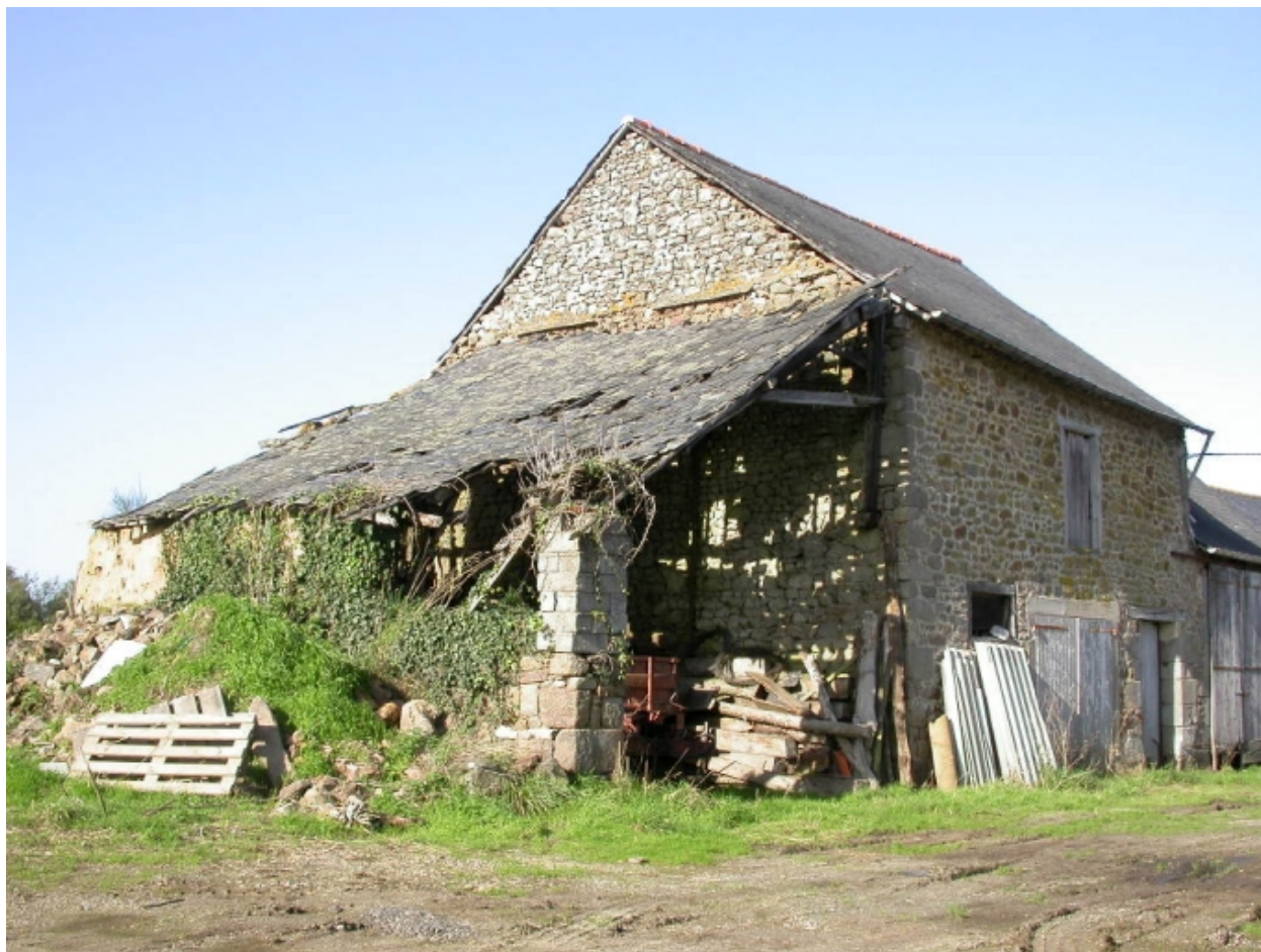
Dépendance située à l'ouest de la cour
