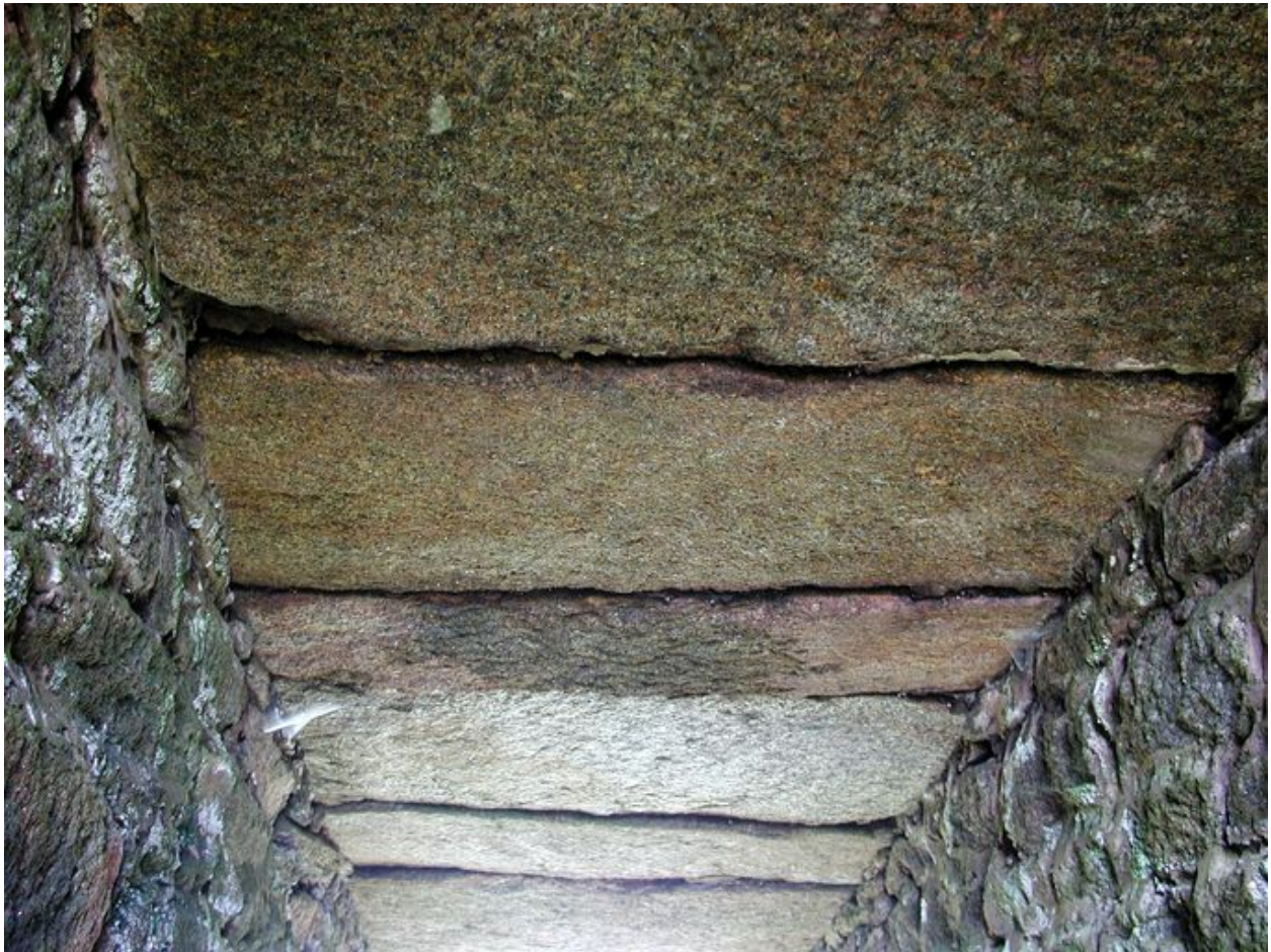
Vue de détail la galerie de communication avec la batterie basse : dalles de couverture (état en 2006)
