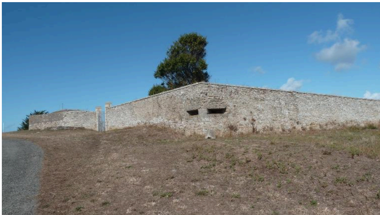
Quiberon, Fort Neuf, enceinte.
