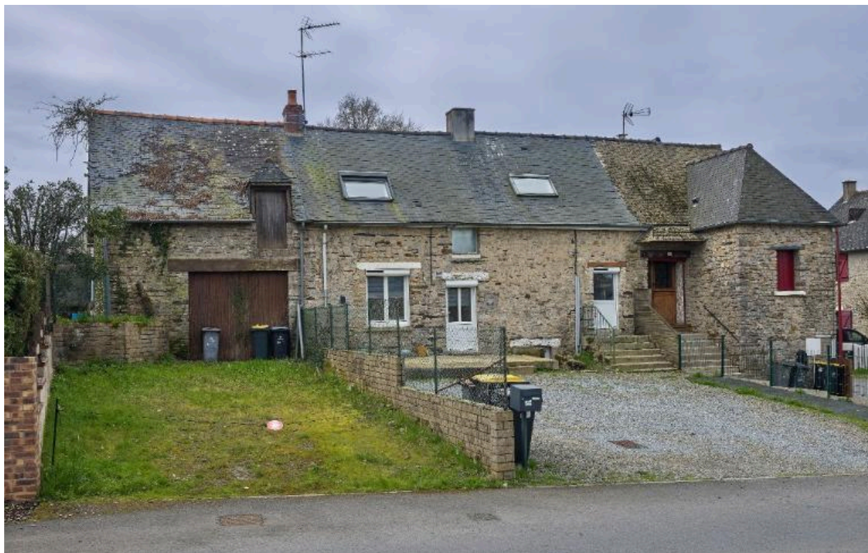
Façade du 7 rue de la Foulquière et 15 rue des Vignes, après réhabilitation
