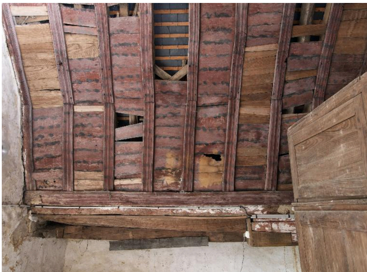
Charpente de la sacristie Sud
