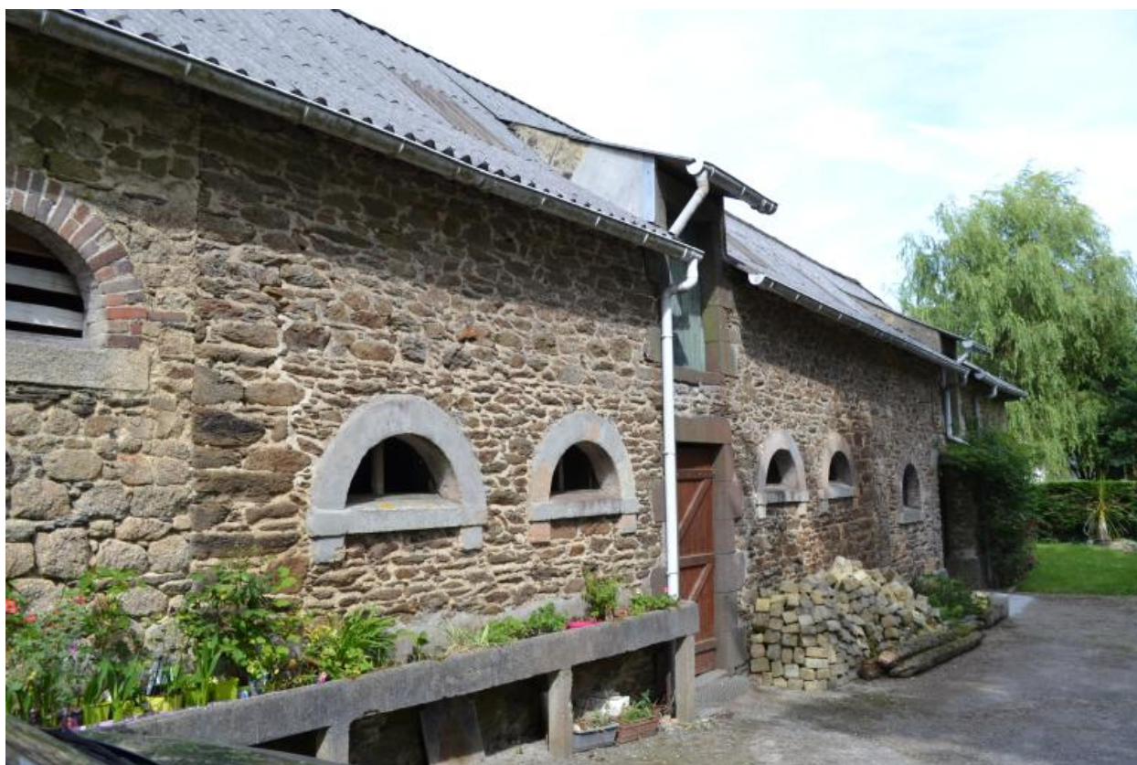
Blanchisserie du Leck. Vue sud-ouest
