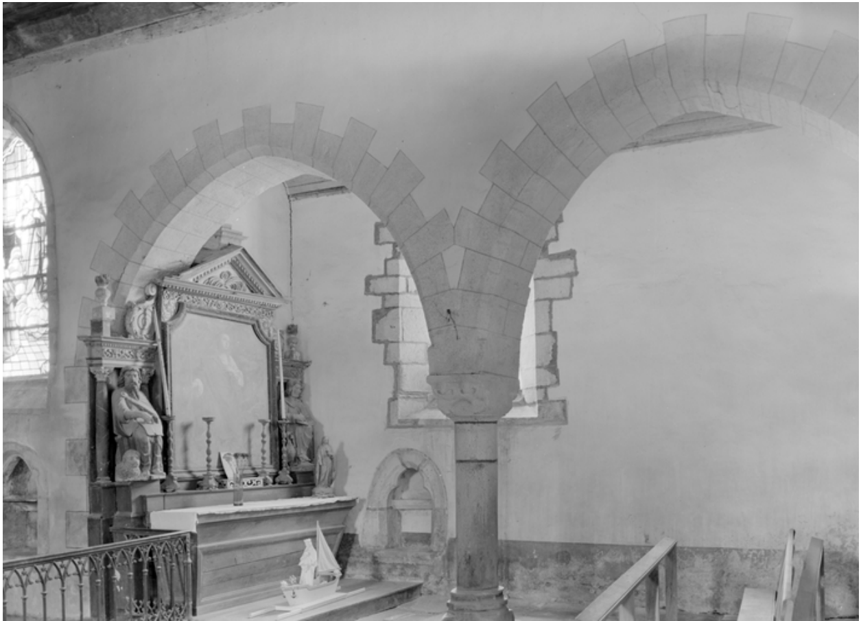
Chapelle Saint-Golven : bras sud du transept (état en 1984)
