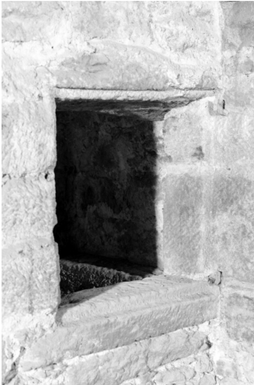
Intérieur, clocher, deuxième étage, niche armoire : vue générale.
