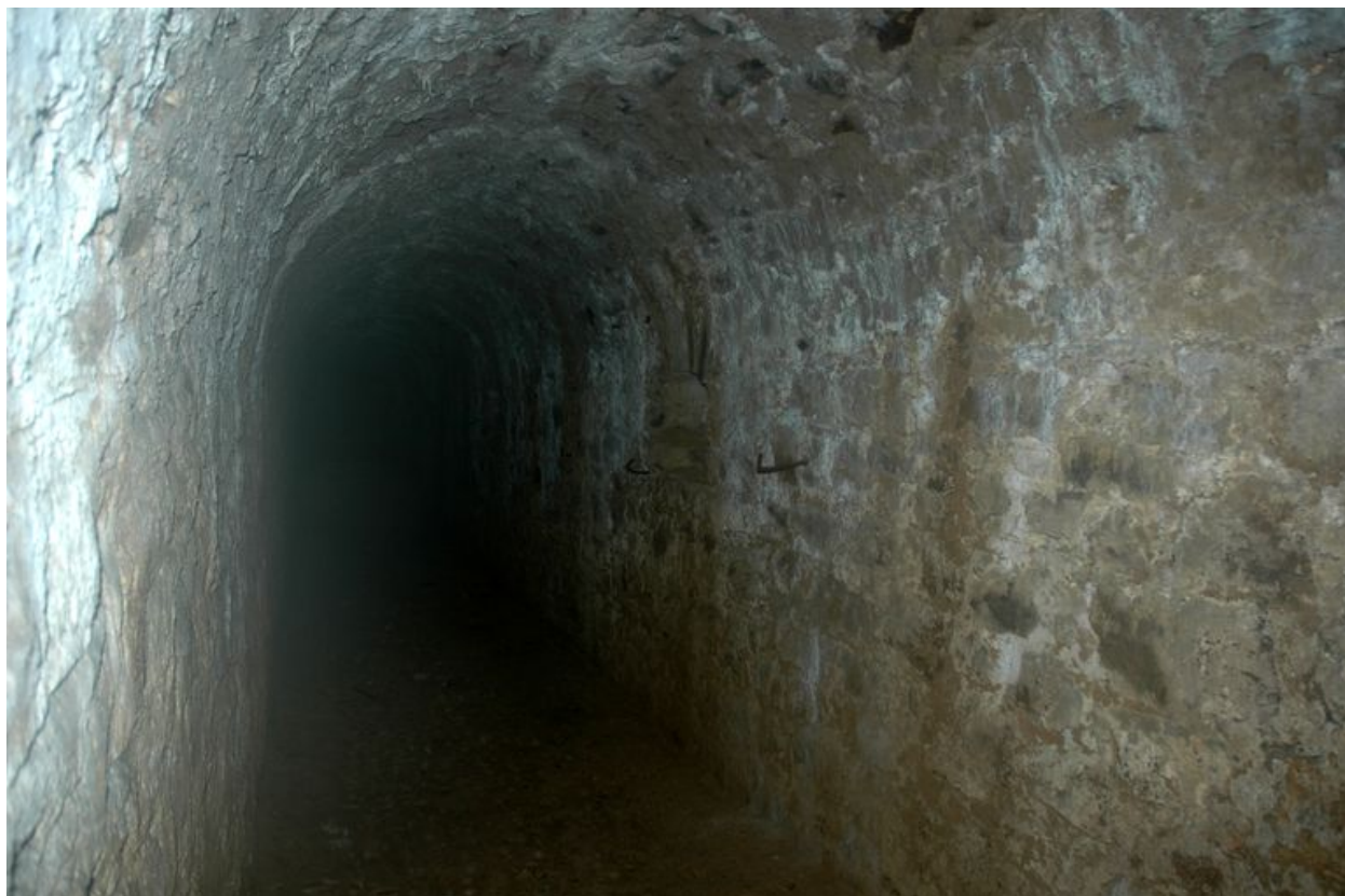
Vue du fort de Penfeld : galerie de contrescarpe
