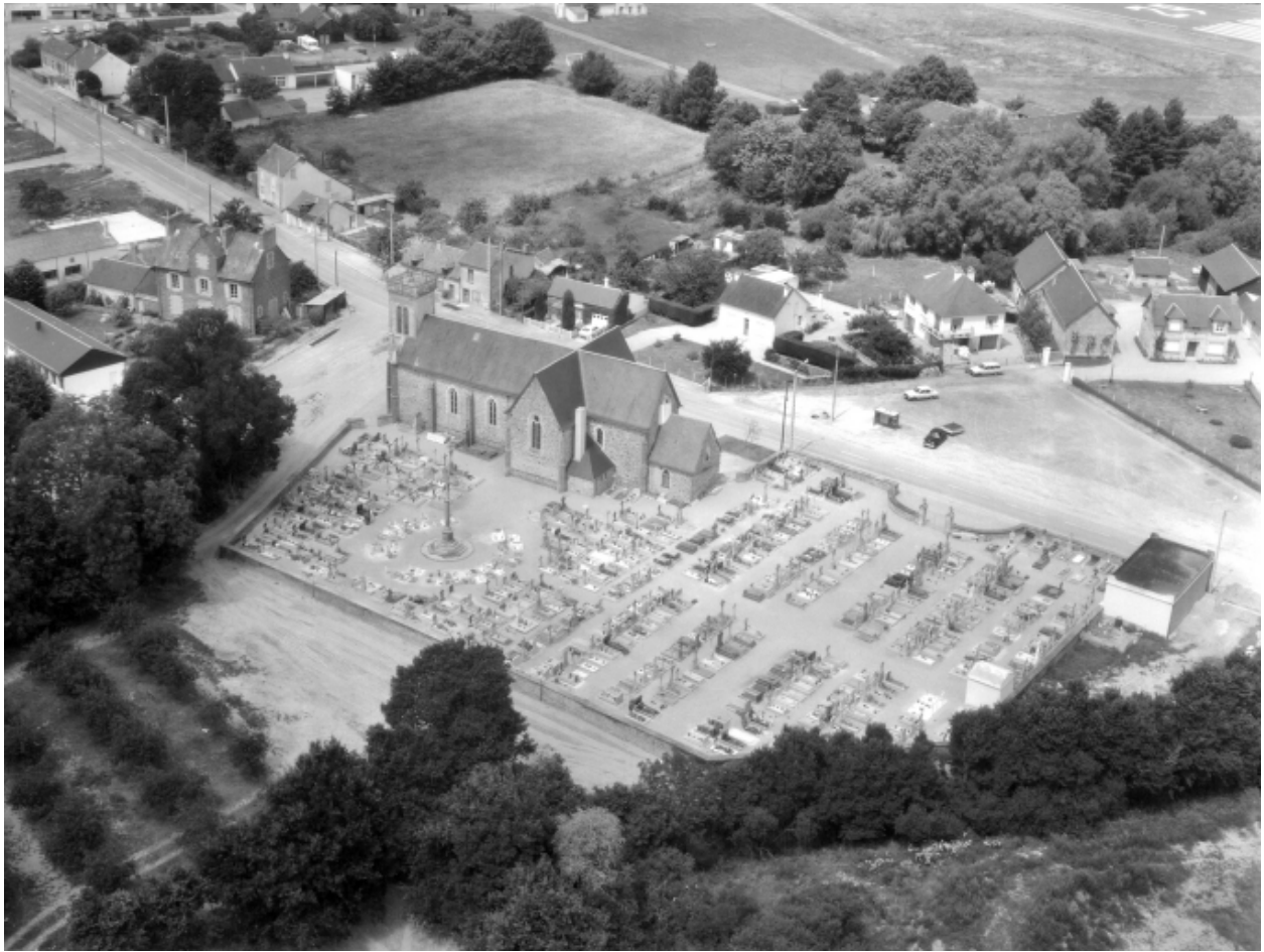
Eglise paroissiale, vue aérienne vers le nord ouest.
