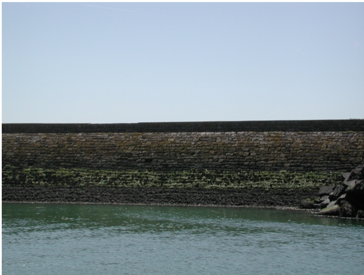
Vue du mur de la jetée de l'avant-port et détail de l'appareillement des moellons
