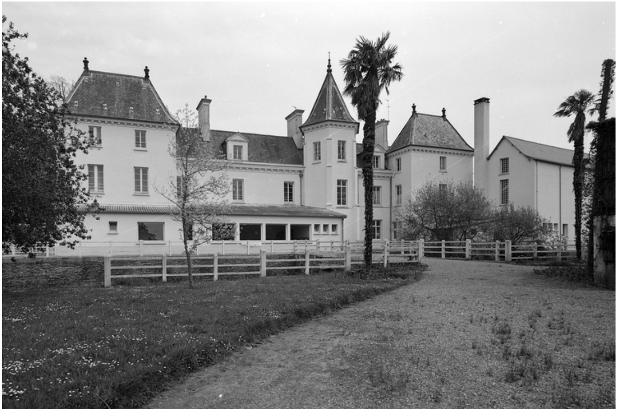
Vue générale façade ouest.
