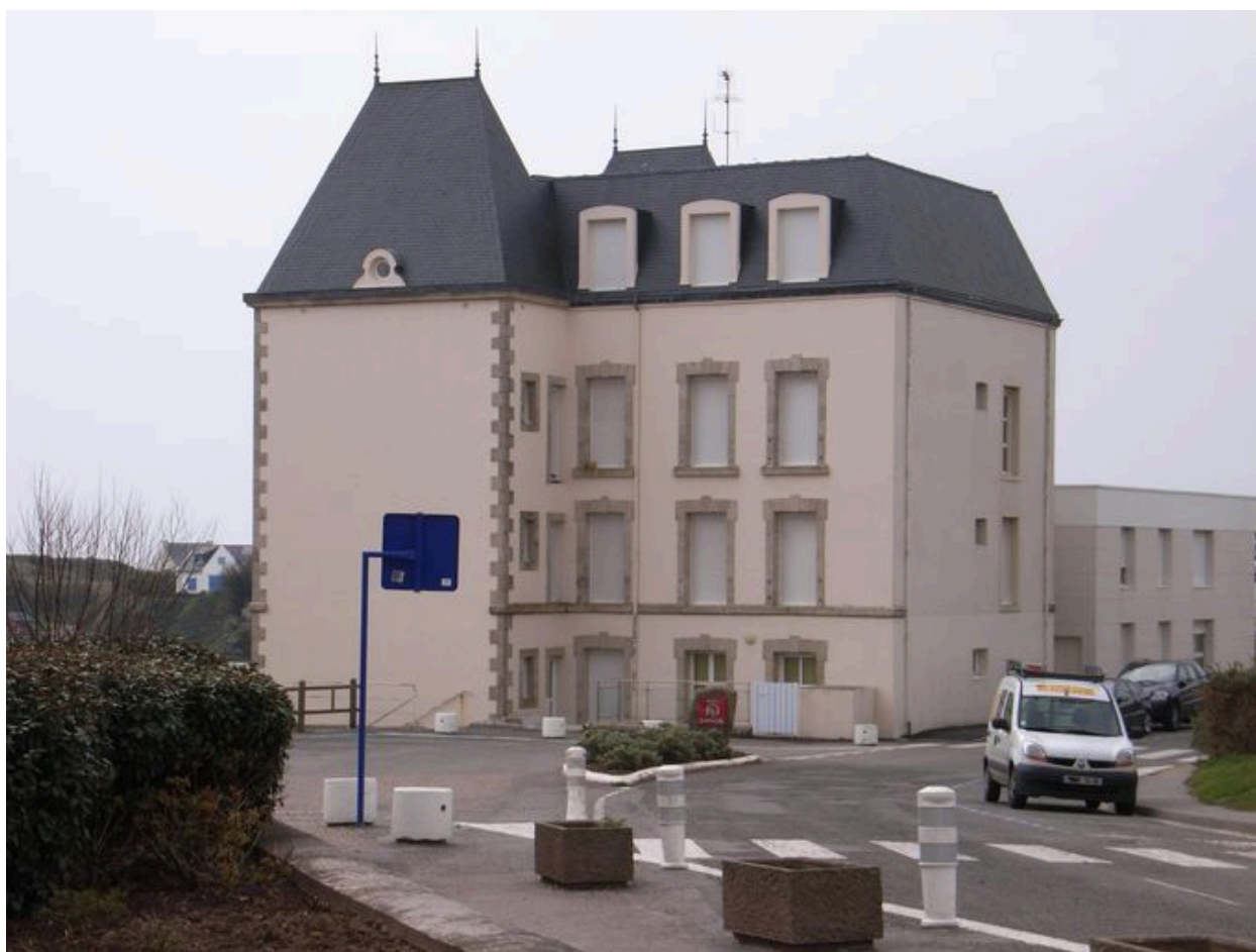
Ancien Hôtel des Bains, côté rue
