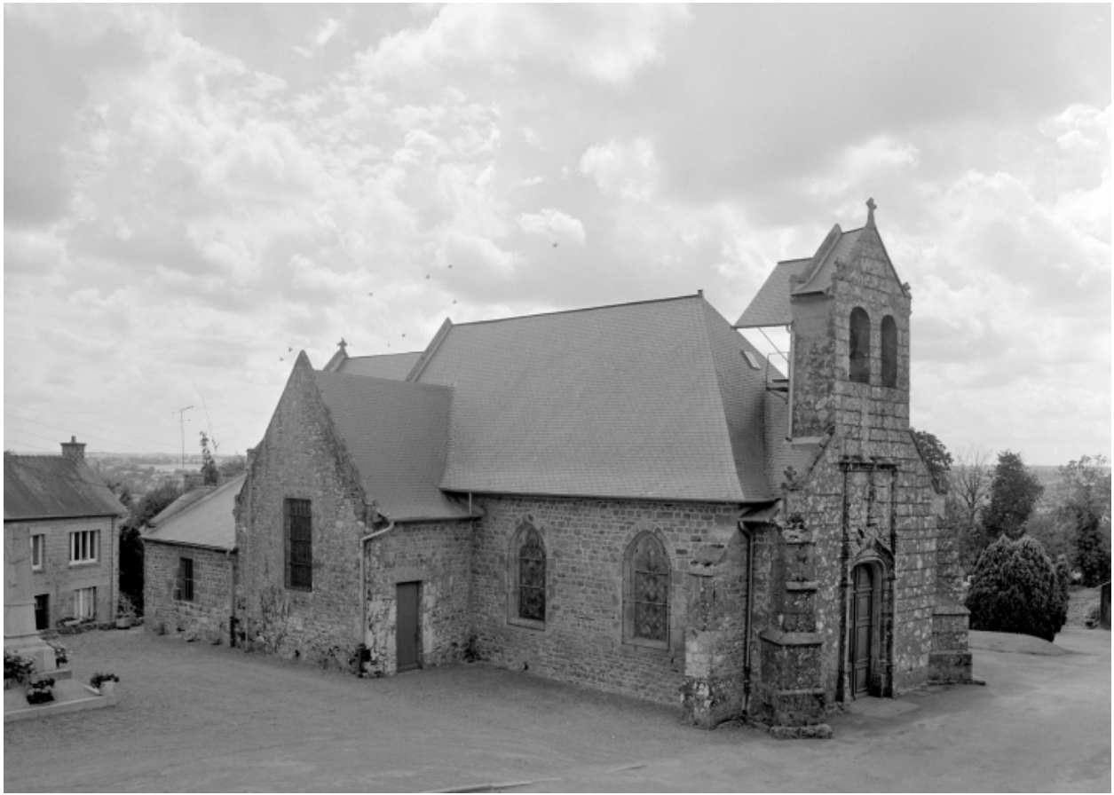
Elévation Nord-Ouest : vue générale
