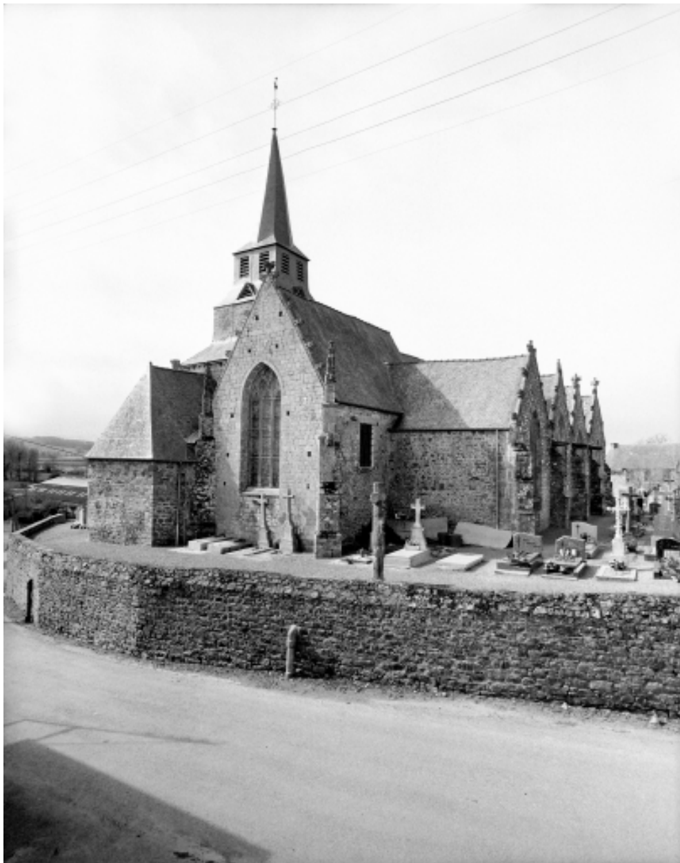
Elévation Nord-Est : vue générale
