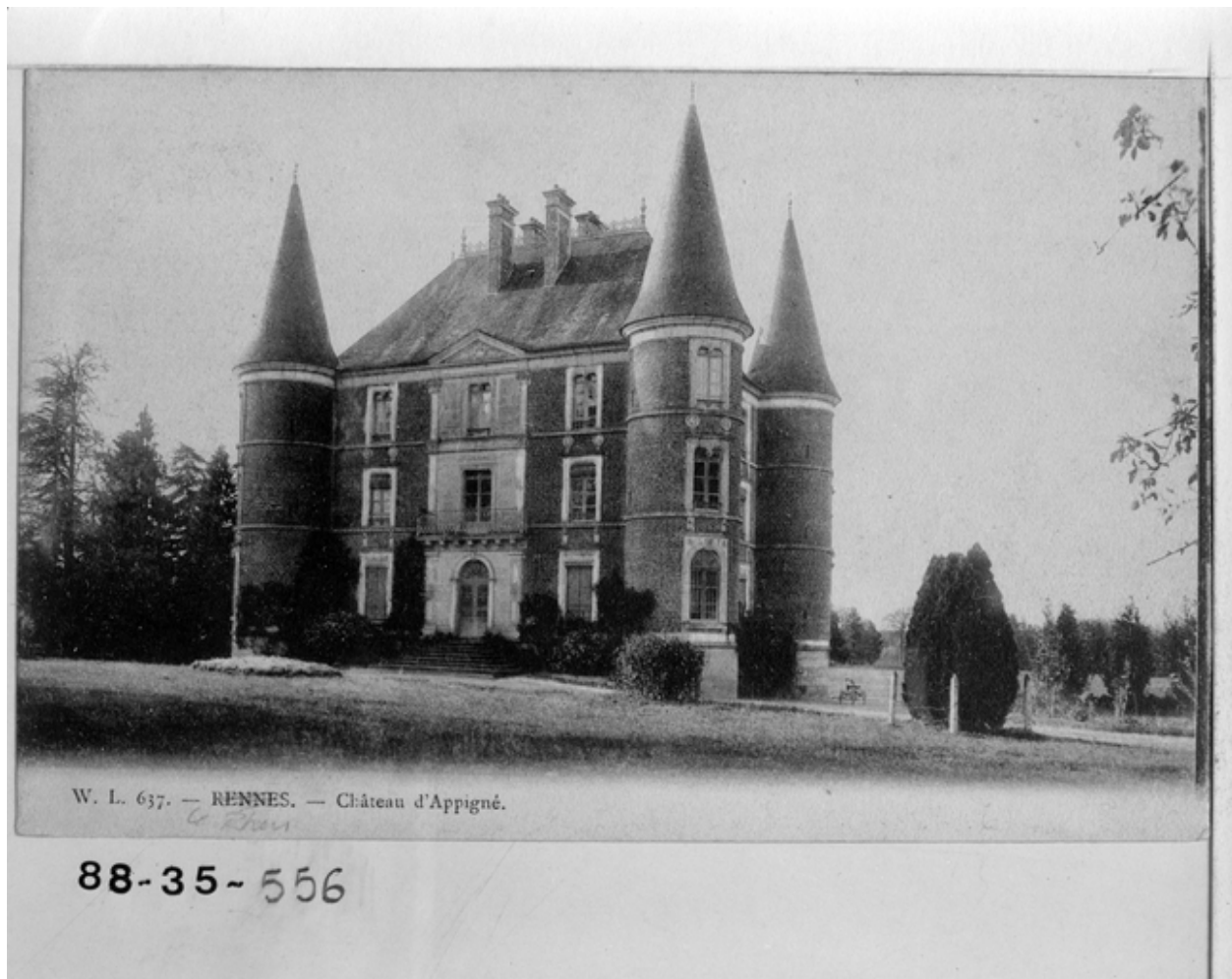
Vue générale façade sud
