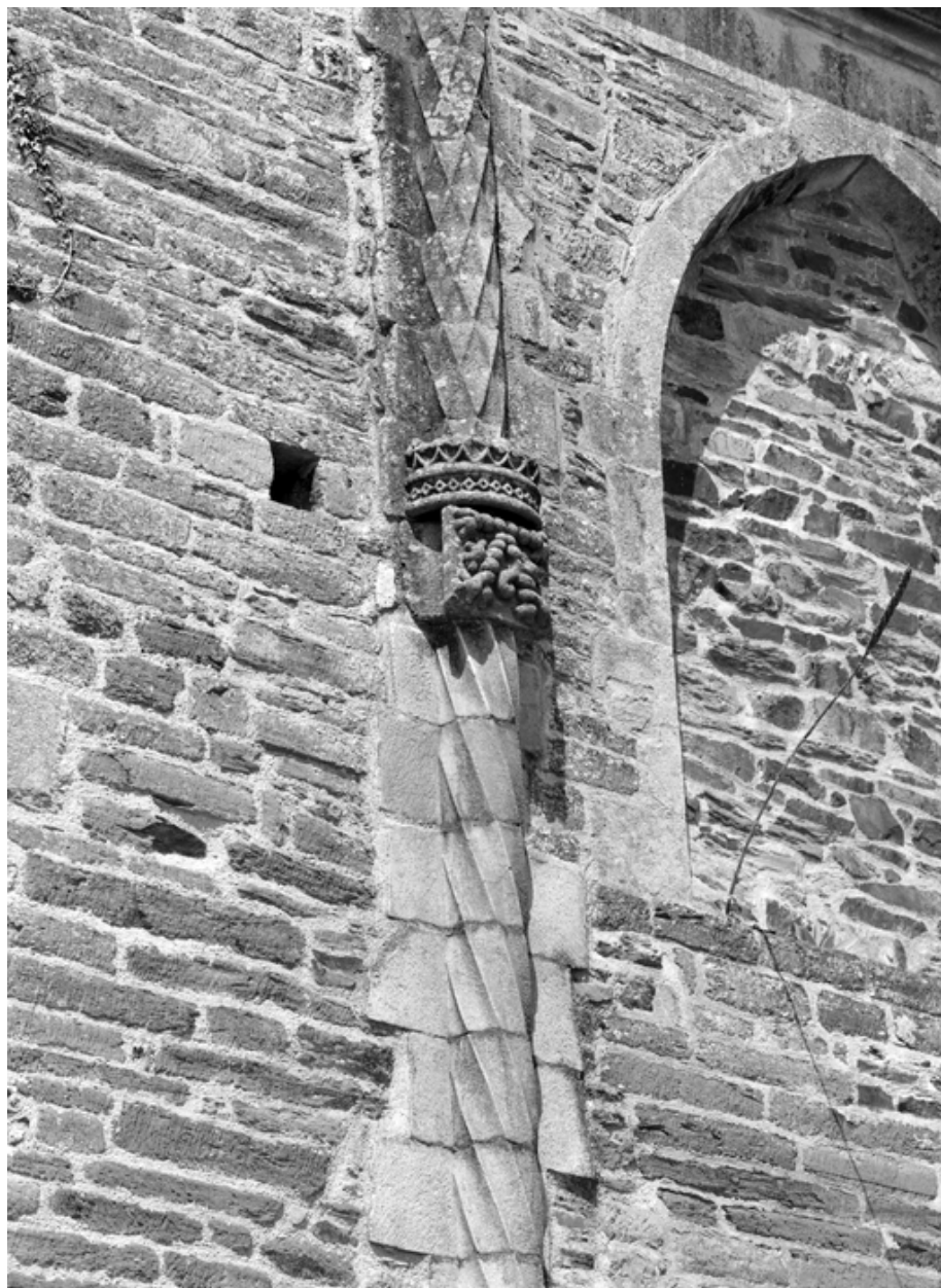
Chapelle, tuyau de descente, détail.
