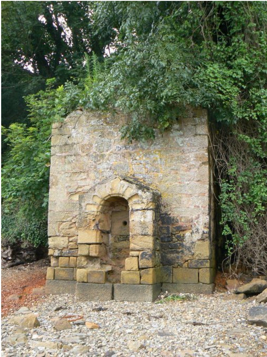
Vue générale de la fontaine de Quéléren
