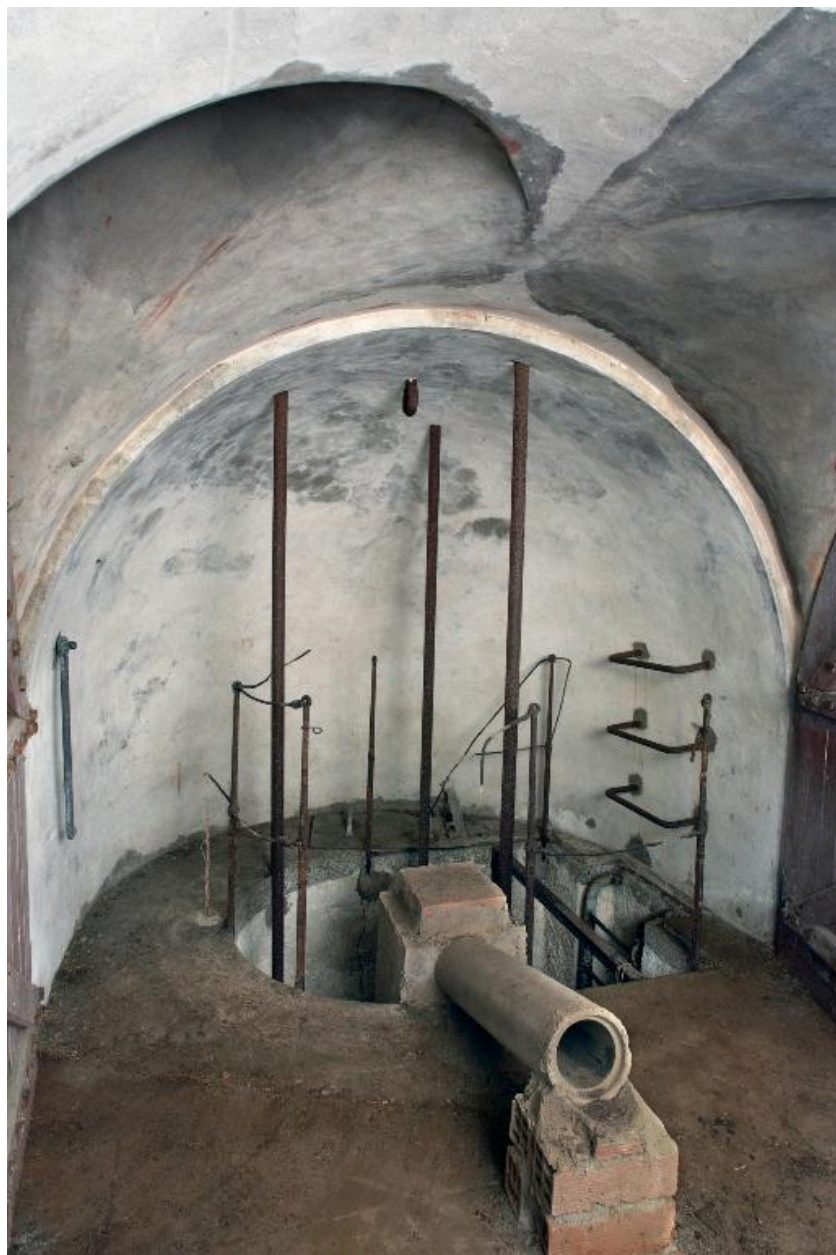
Vue intérieure de la niche de protection du puits du monte-charge du magasin à poudre sous roc. Il est doublé d'une échelle
