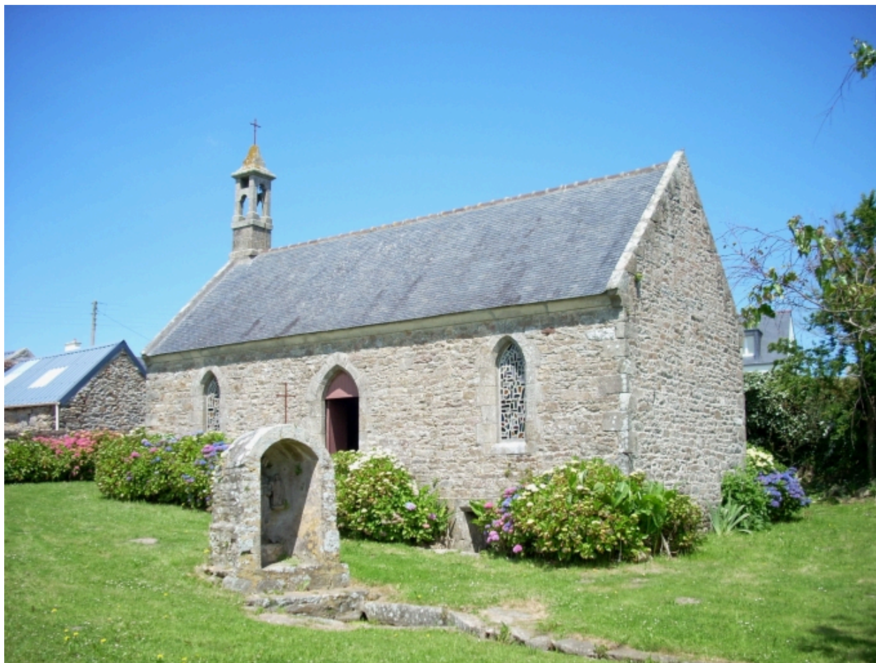
Ploudalmézeau, chapelle Saint-Eloi : vue générale sud-est
