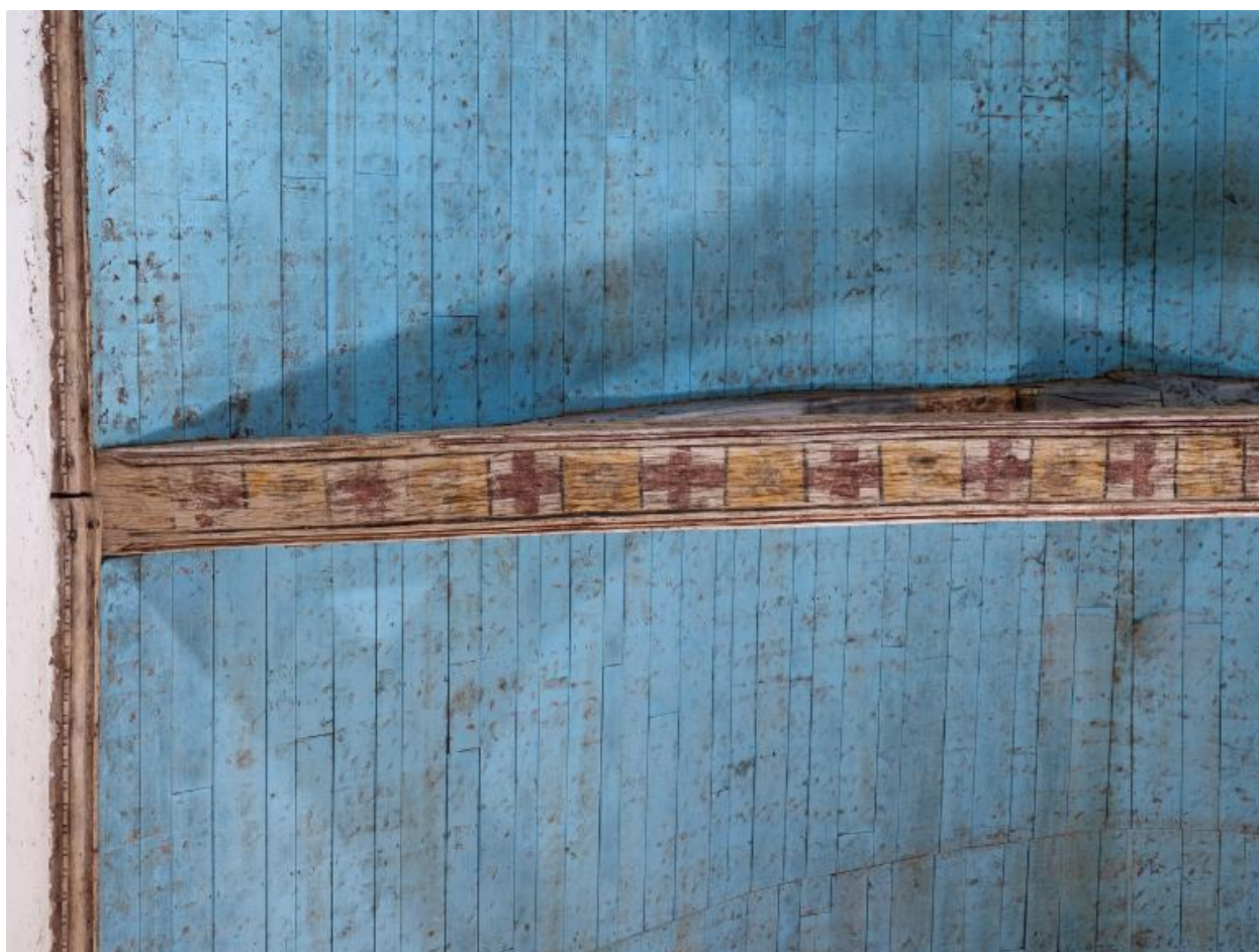
Charpente de la nef ; entrant à décor de fleurs noires et de croix rouges
