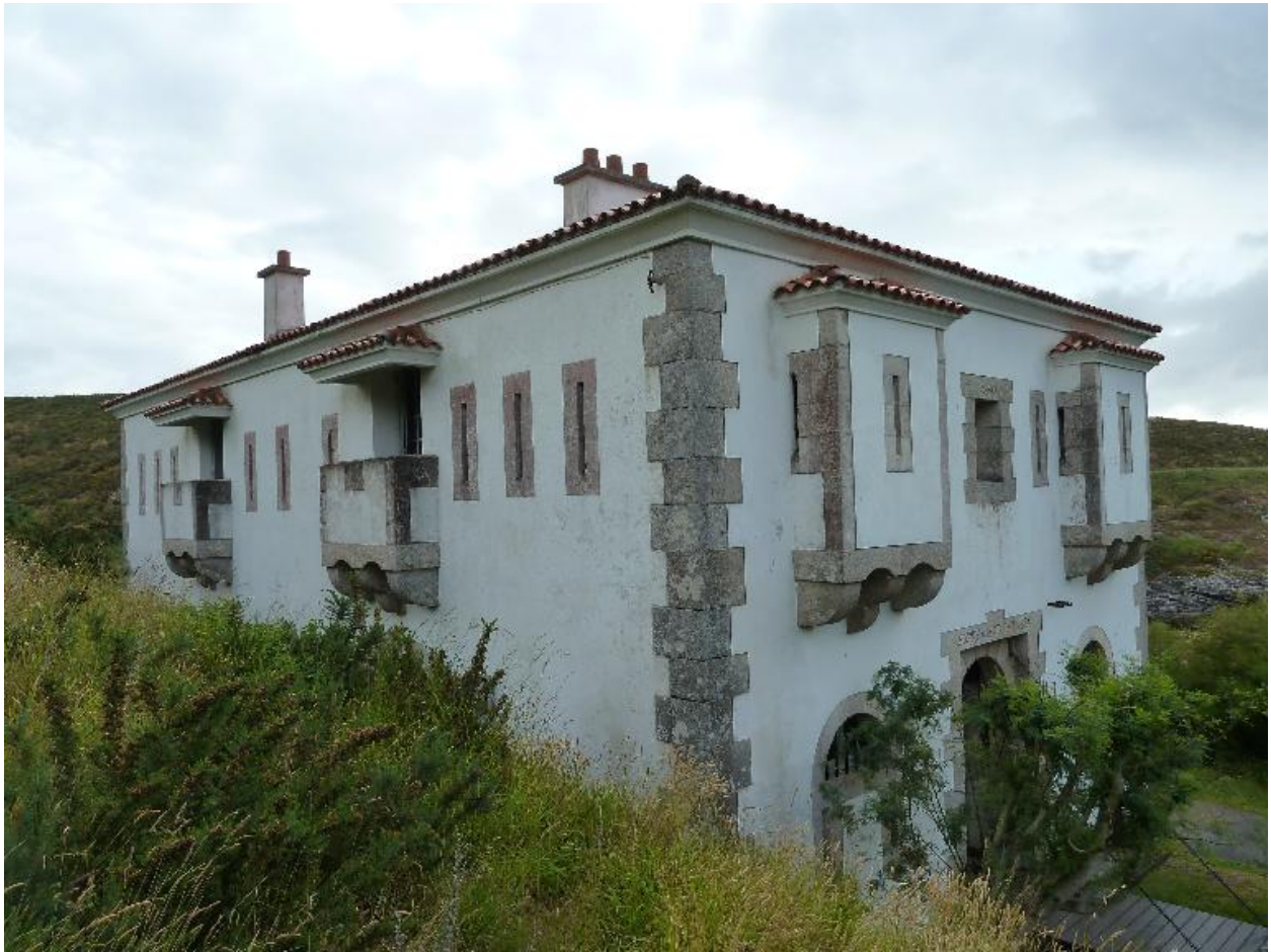
Locmaria, Port Maria, corps de garde crénelé, angle sud-ouest.
