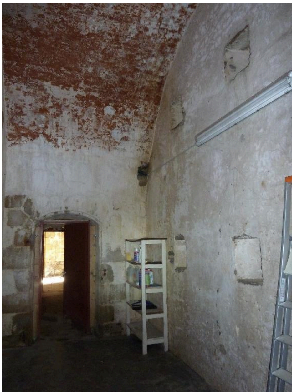
Le Palais, enceinte urbaine, réduit B, vestibule du magasin à poudre.
