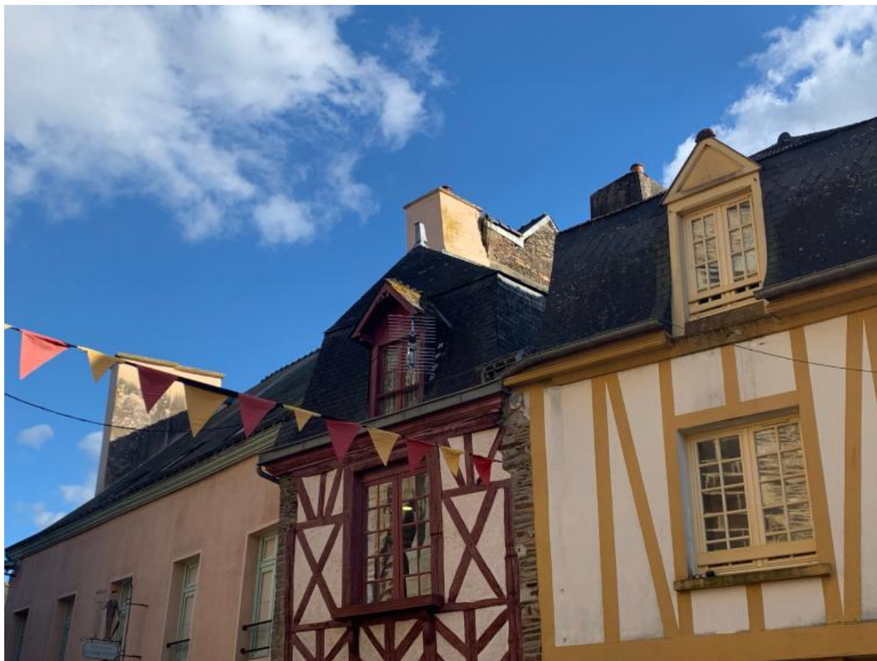
Elévation nord-ouest, premier étage en pan de bois
