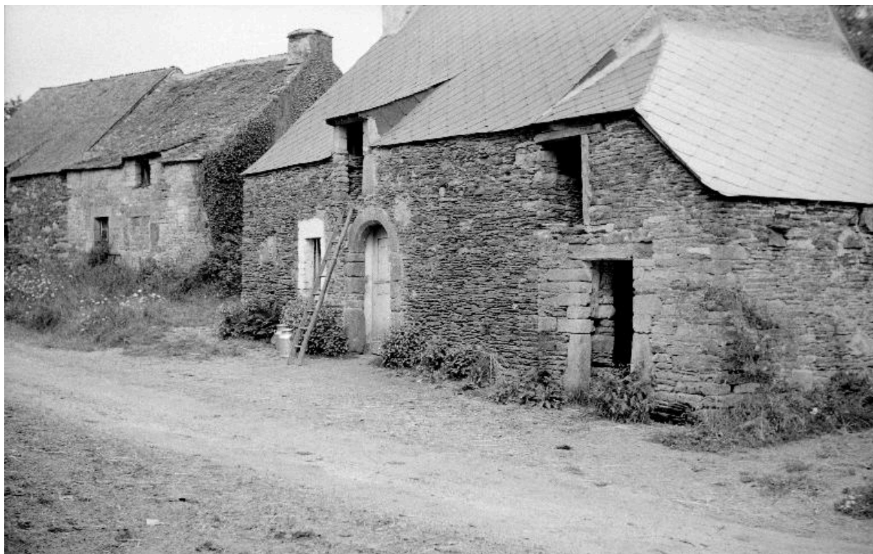
Ferme 33 (état en 1969)
