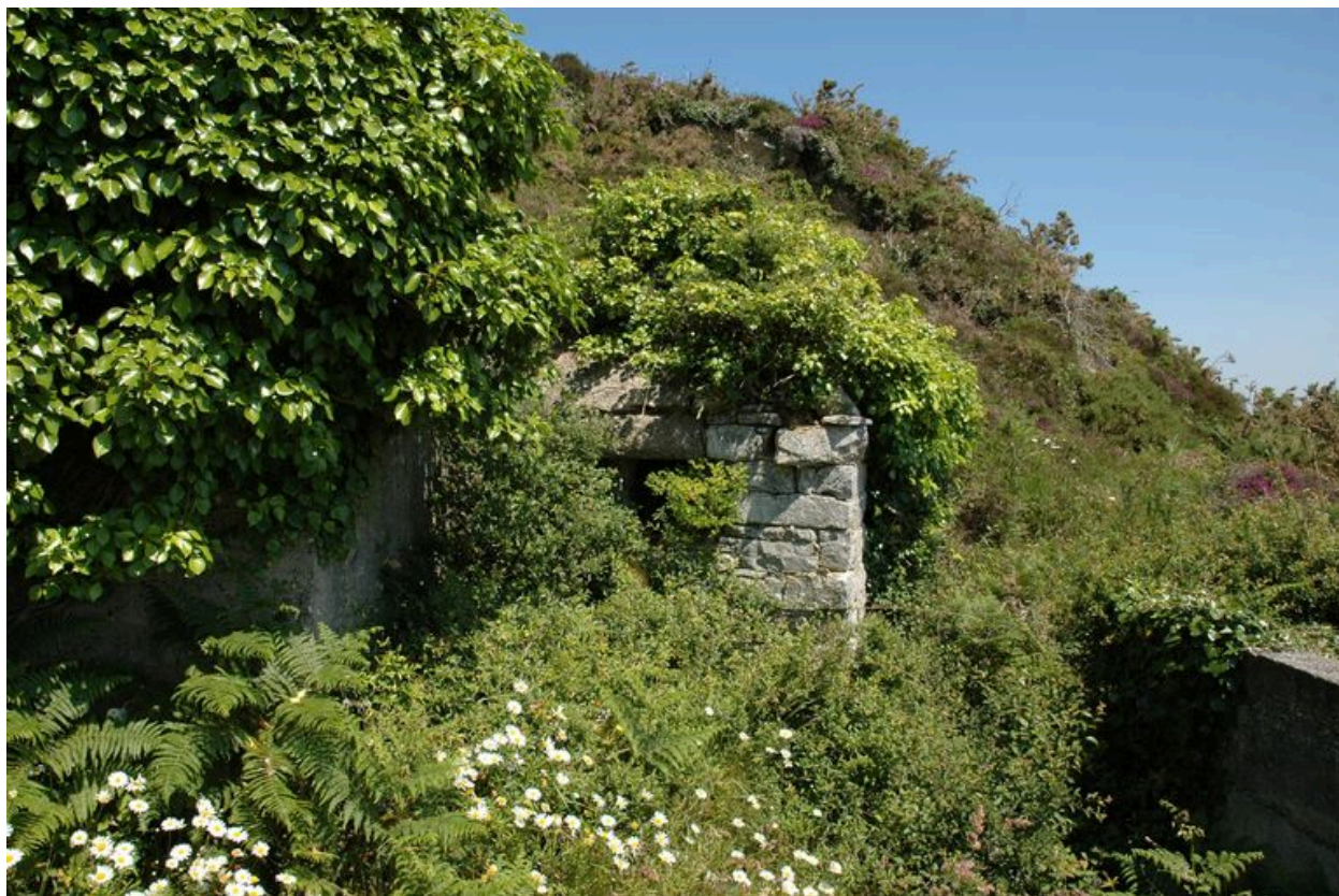
Vue de la guérite d'observation en maçonnerie de moellon située au niveau de la batterie de côte (état en 2005). Elle est envahie par la végétation
