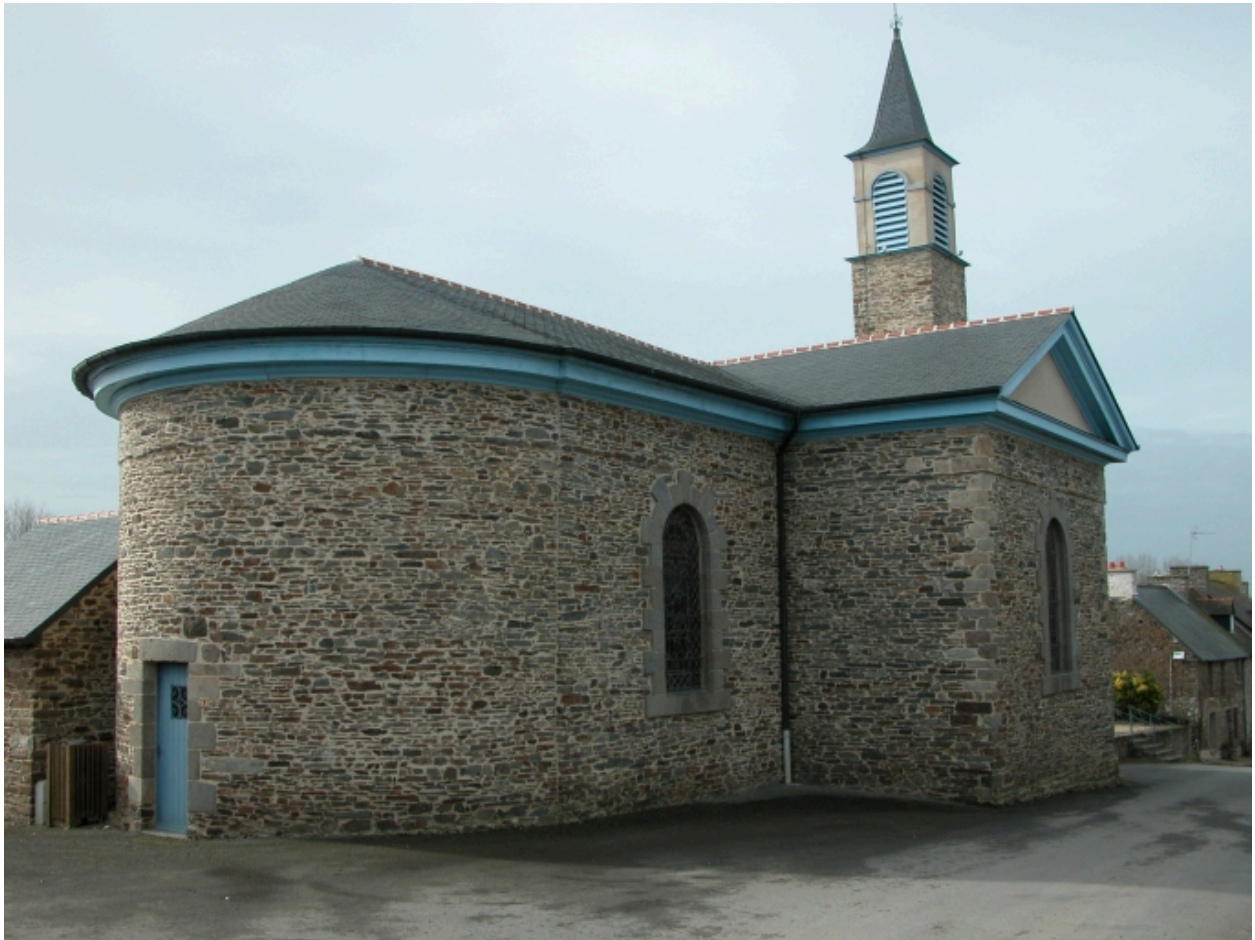
Elévation Nord-Est : vue générale
