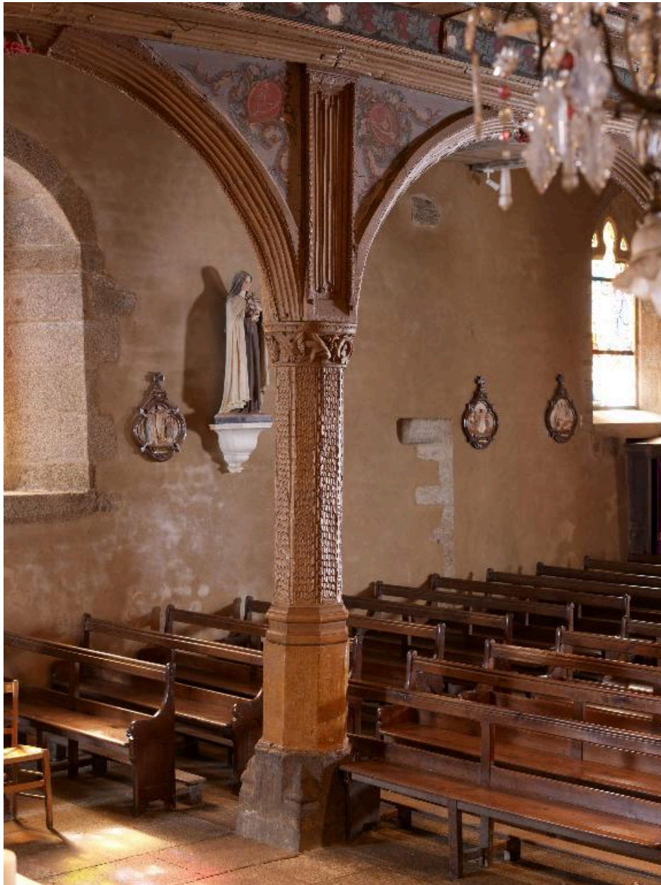
Vue générale d'un pilier entièrement en bois
