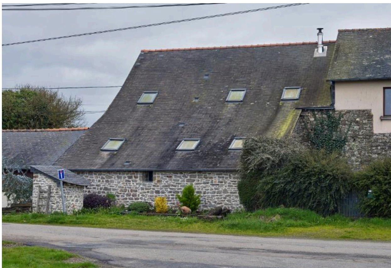
Façade postérieure nord de la maison et son puits associé au 26 La Violais
