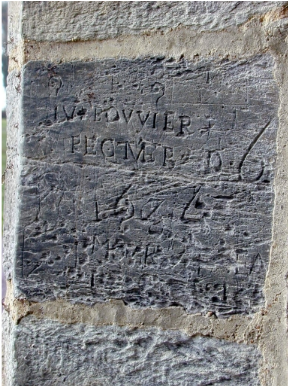
Détail : façade nord, porte à coussinets, inscriptions du 17e siècle : ' IV[?] BOUVIER RECTMER D 6 1674 [...]'
