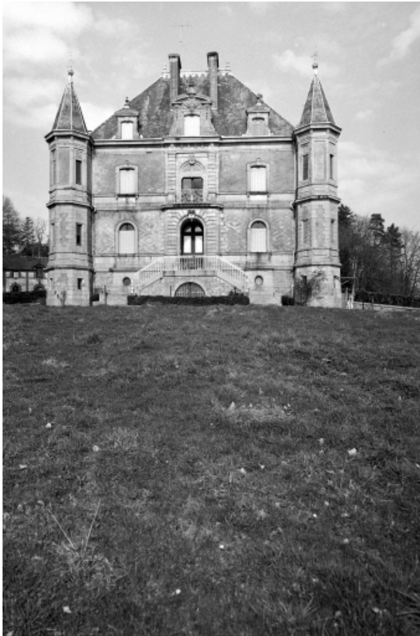
Façade sud, vue générale.
