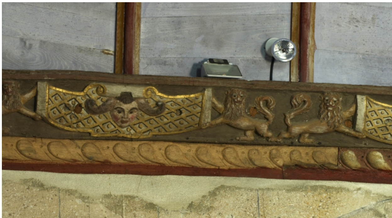
Intérieur, mur nord de la nef, détail de la sablière
