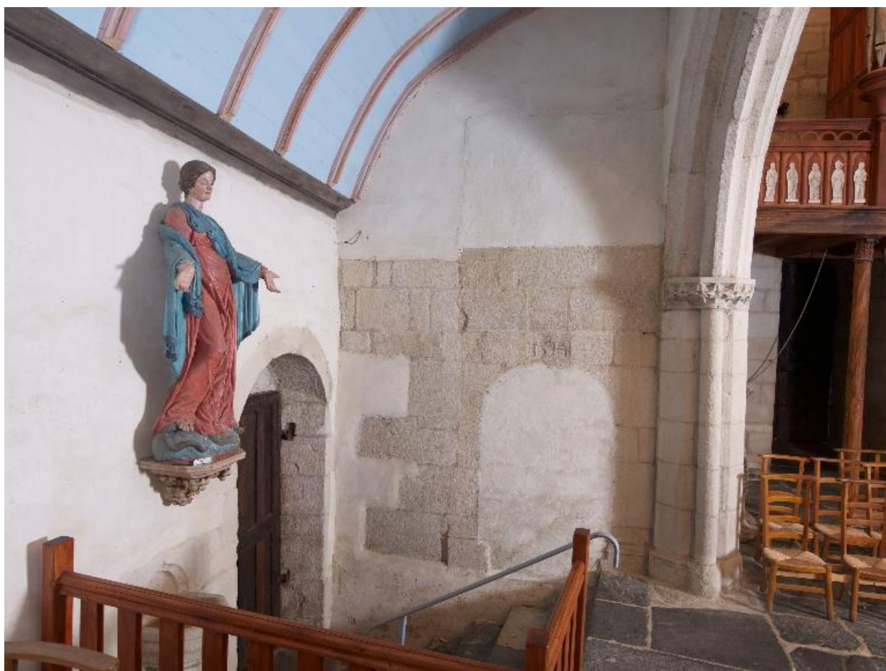
Bas-côté sud, bas de la nef
