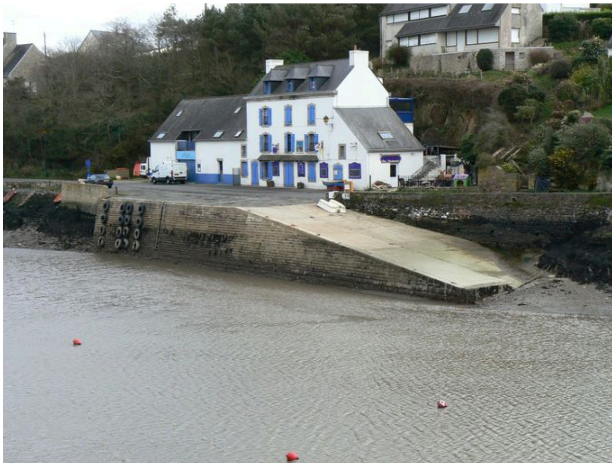
Quai Neuf et extension septentrionale du front portuaire de Kernabat
