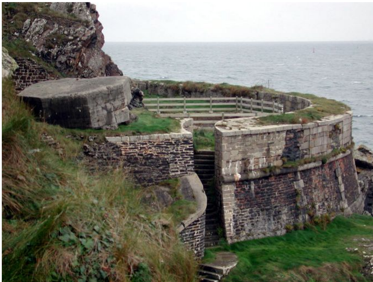
Vue de la batterie de Cornouaille depuis la batterie de Beaufort
