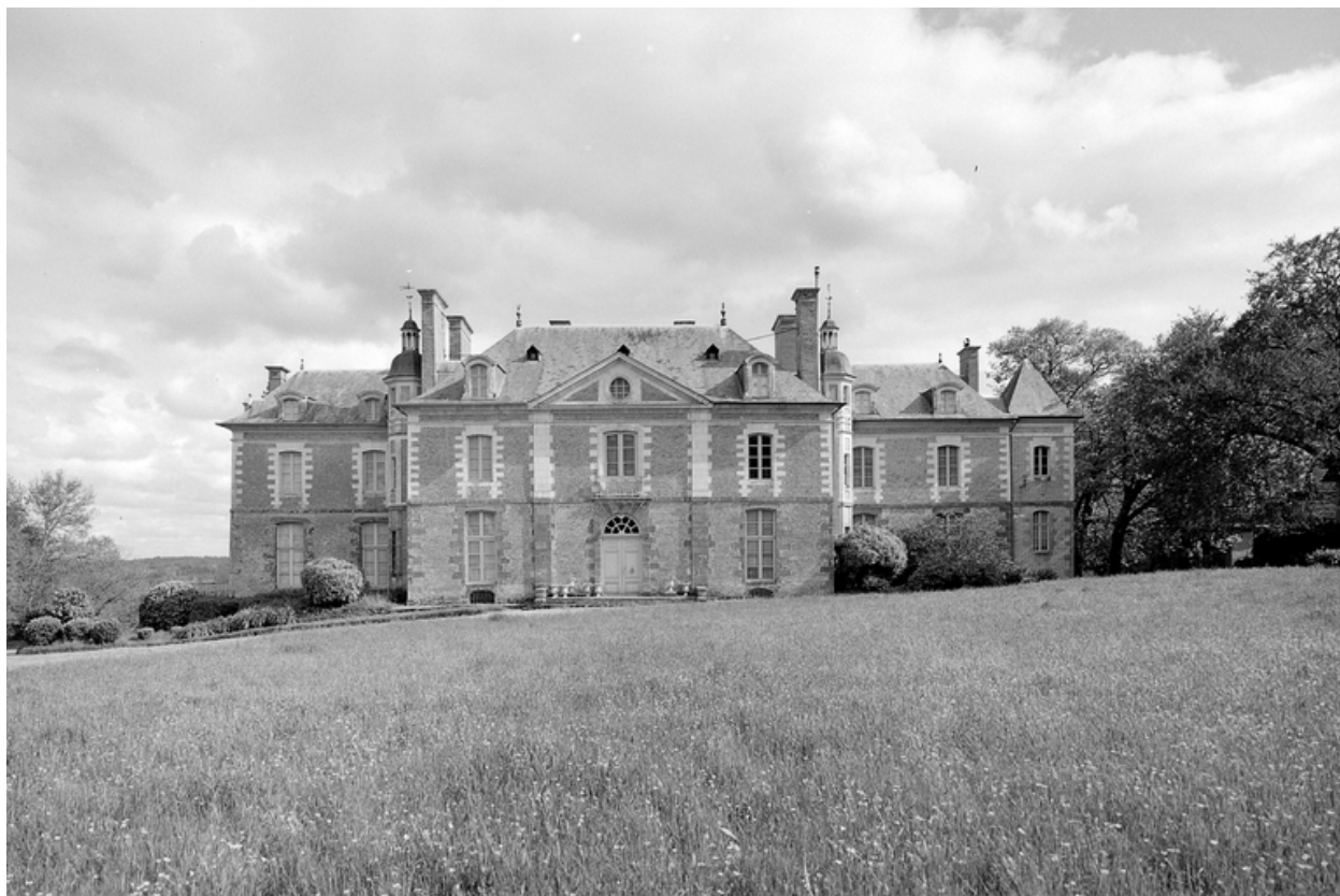
Vue générale nord.
