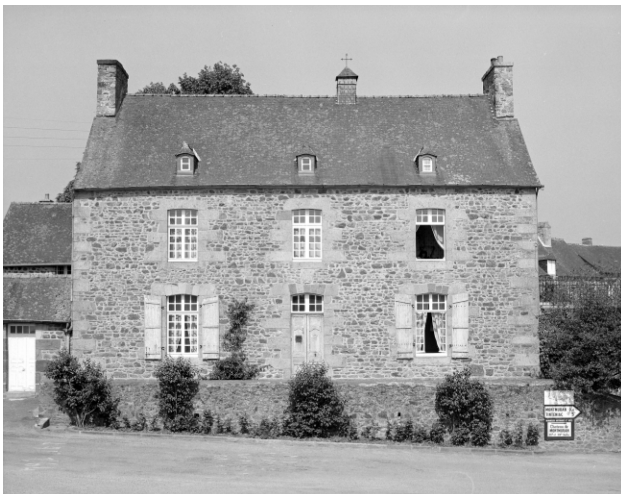
Façade antérieure, vue générale.
