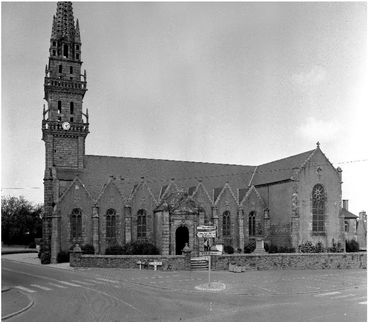
Église : élévation sud prise du sud-ouest (état en 1986)
