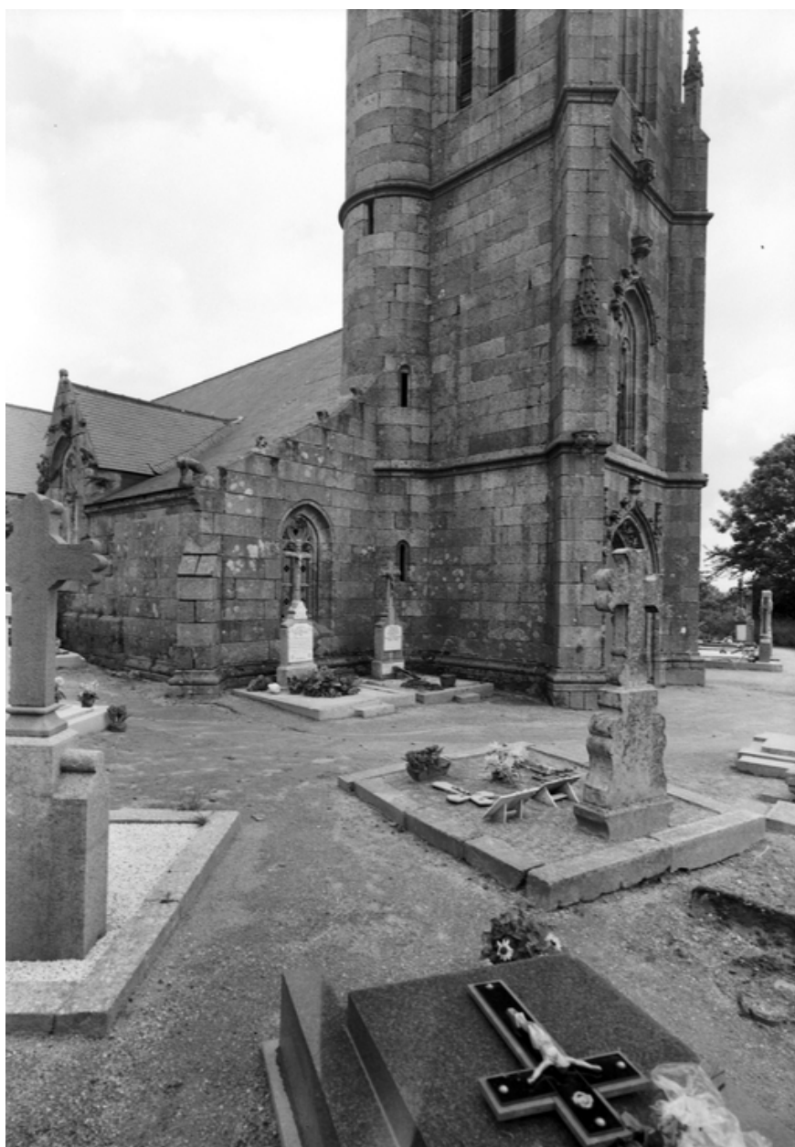
Fenêtre ouest du bas-côté nord
