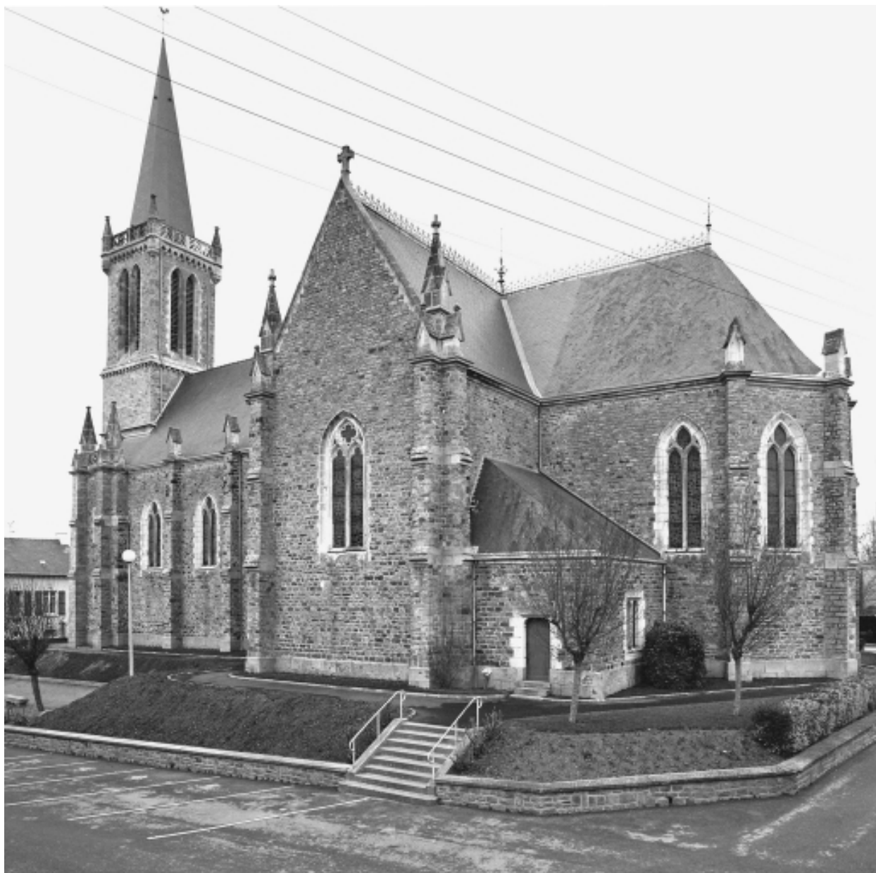
Elévation sud-est : vue générale
