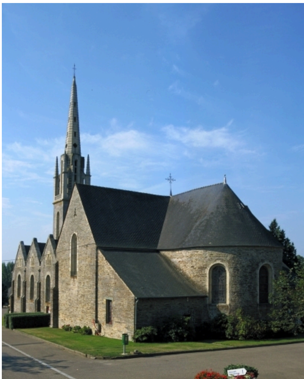
Élévation nord : vue générale
